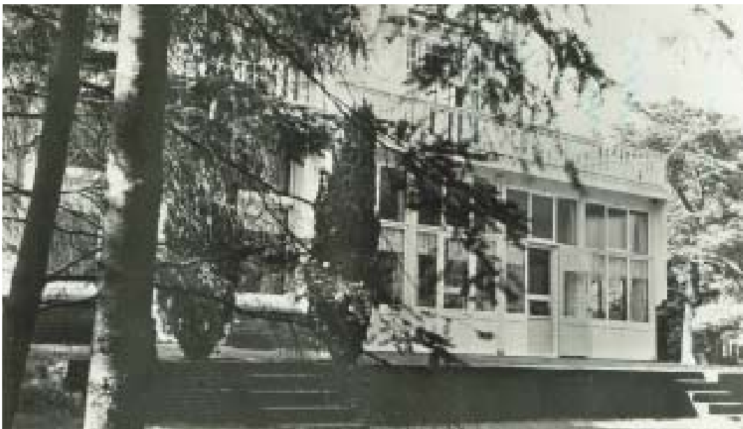
Villa achtergevel met aangebouwde serre
