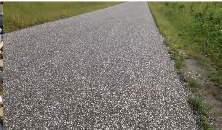
Asfalt afgestrooid met split als verharding voor het erf.
