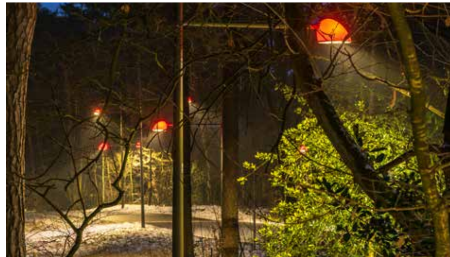
HERKENBARE MASTEN EN ARMATUREN LANGS DE KERCKEBOSCHLAAN
