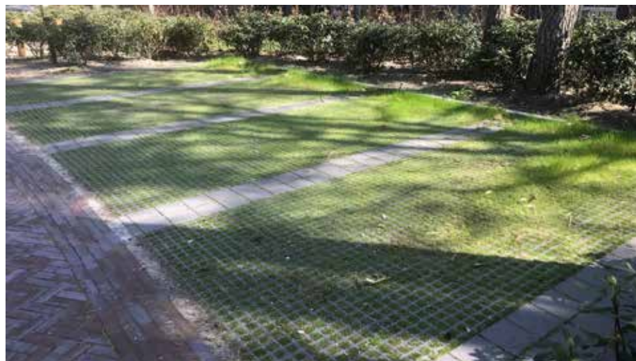
PARKEERVAKKEN VAN OPEN GRASBETON
