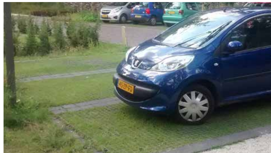
PARKEREN OP GRASBETONSTENEN
