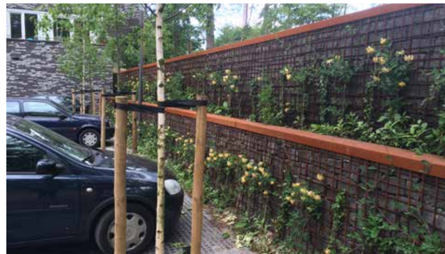
GETRAPTE KEERCONSTRUCTIE MET TURFBLOKKEN
