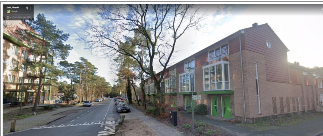
Figuur 30 – Prinses Marijkelaan zuidzijde met rijenwoningen in 3 bouwlagen met flauwe kap. (Bron: Google Streetview)
