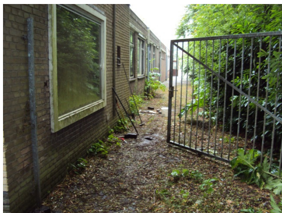
Foto 4: ter hoogte van boring 3001 (in zuidelijke richting)
