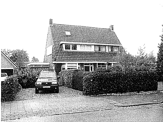
Foto 1: Overzicht van de locatie met op de voorgrond de oprit van de Julianalaan 11
