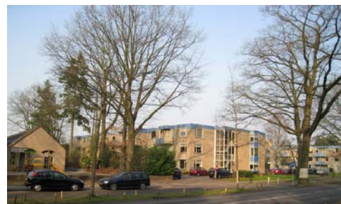
Basisschool en appartementengebouw aan de Oranje Nassaulaan
