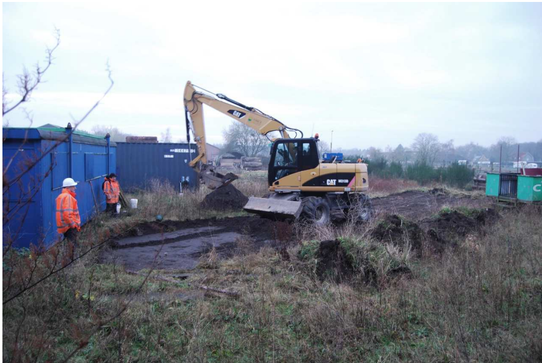
Afbeelding 13 Austerlitz-Hubertweg 31. Impressie van de start van het onderzoek. Bron: foto Vestigia (15-12-2015).
