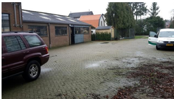
Foto 1: situering locatie vanuit noordoostelijk richting
