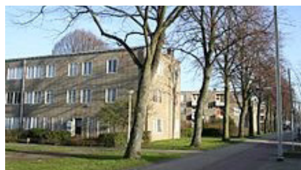
Amsterdam-Burgemeester De Vlughtlaan, Airey woningen in 3 bouwlagen door J.F. Berghoef, 1953
