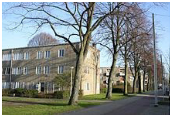
Amsterdam-Burgemeester De Vlughtlaan, Airey woningen in 3 bouwlagen door J.F. Berghoef, 1953
