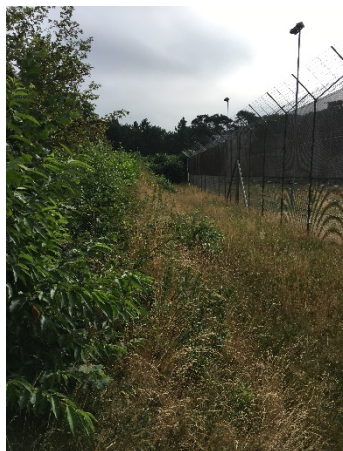
Foto 5: Links de talud en recht het voormalige sportveld met kruidachtige planten.
