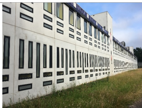
Foto 2: achterzijde van de gevangenis
