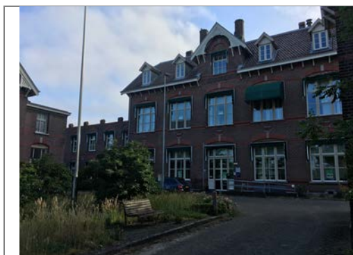
Foto 1: Het gevangenisgebouw met links en rechts een dienstwoning
