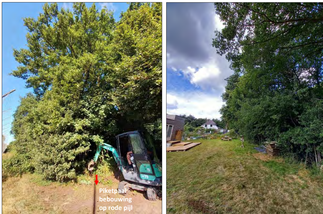
Een impressie van de werkzaamheden op de projectlocatie.
