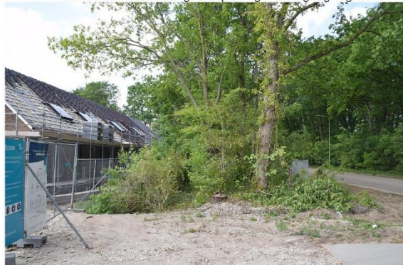
7. De afstand tussen bebouwing en beplanting in naastgelegen gebied
