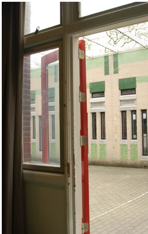
Buitengevel van ruimte 0.12.22 – kozijnen zijn in de jaren '60 voorzien van voorzetkozijnen en nieuwe deuren. Aan de binnenzijde is het oorspronkelijke kozijn nog te zien.
