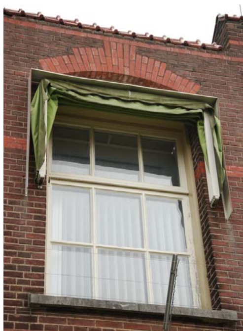
Verdieping, rechter geveldeel, 2 e vensteras van links: vast onderraam, vallend bovenlicht
