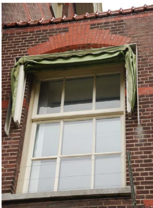
Verdieping, rechter geveldeel, 1 e vensteras van links: onderraam uitgevoerd als schuifraam
