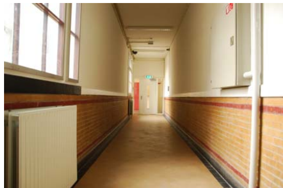
Eerste verdieping, rechter verbindingsgang. Het oorspronkelijke gangbeeld: een 'lambrisering' van gele verblendstenen met rode banden.
