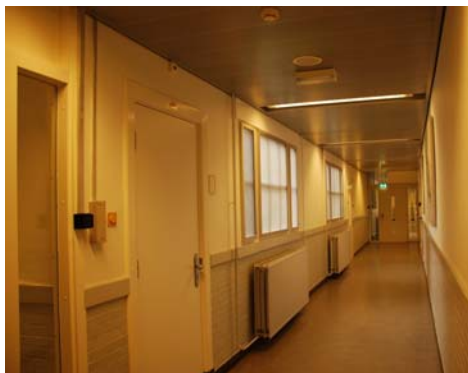
Begane grond – linker verbindingsgang. Onderste strook metselwerk is nog aanwezig maar is witgeschilderd.
