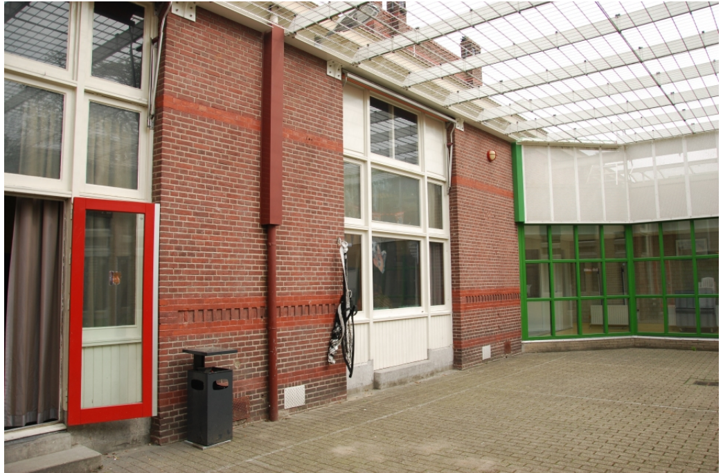
Buitengevel van ruimte 0.12.22 – kozijnen zijn in de jaren '60 voorzien van voorzetkozijnen en nieuwe deuren. Aan de binnenzijde is het oorspronkelijke kozijn nog te zien.
