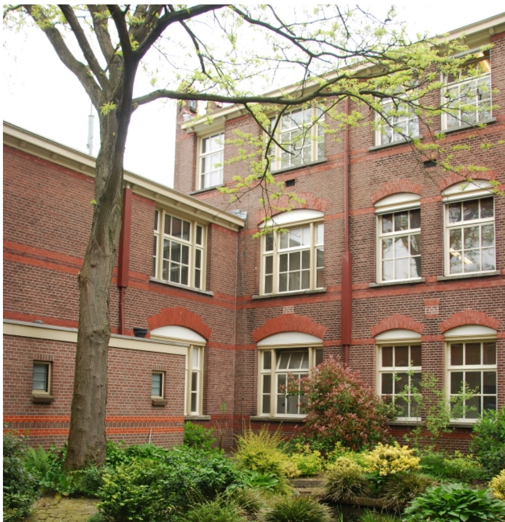
Zicht vanuit de binnentuin op de linker verbindingsgang en de voorgevel van de eerste vleugel achter de hoofdbouw, gebouwd in 1904. In 1908 is deze vleugel met een tweede verdieping opgehoogd.
