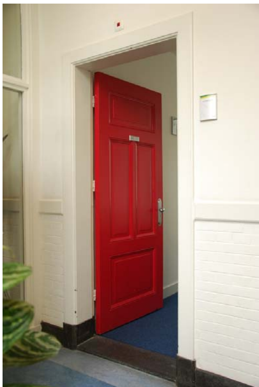
Oorspronkelijke paneeldeur (ruimte 1.04.02)
