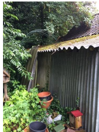
Figuur 9: Dak en wanden bebouwing
