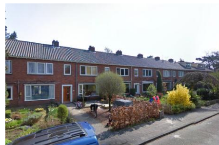
Woningbouw (aaneengebouwd / rij) aan de Hermelijnlaan
