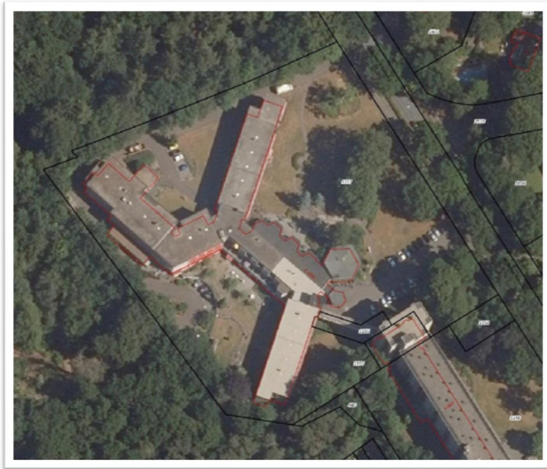
Afb. 4. Huidige situatie op de onderzoekslocatie (bron: opdrachtgever).
