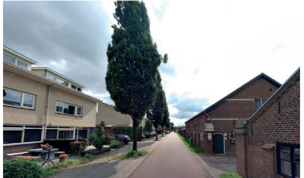
Aanzicht vanuit westelijke kant Hoge dijk richting woningen
