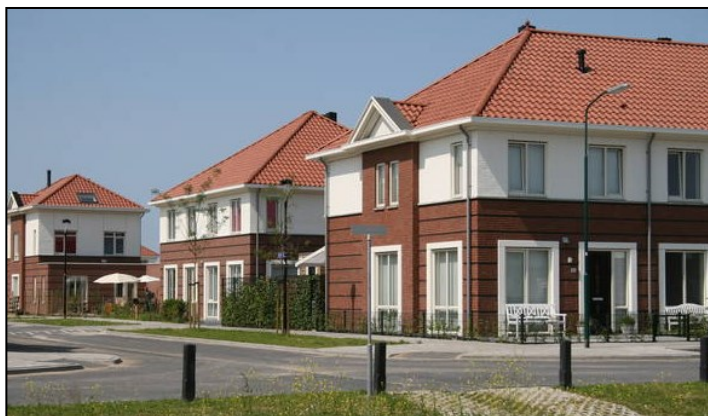
Nieuwe woningen in de wijk De Geer II
