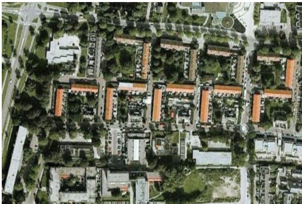
Kenmerkende stempelbouw in 'De Engk'. Bron: Google Earth
