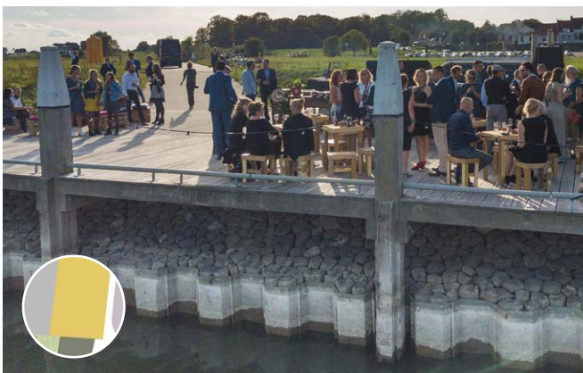
Vaste steiger met houten constructie
