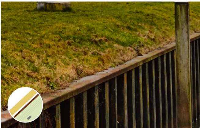
Bestaande kades: stalen damwand met stalen afwerking
