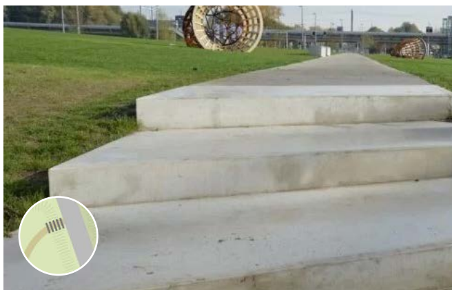
Betonnen treden t.p.v. hoogteverschillen in struipaden
