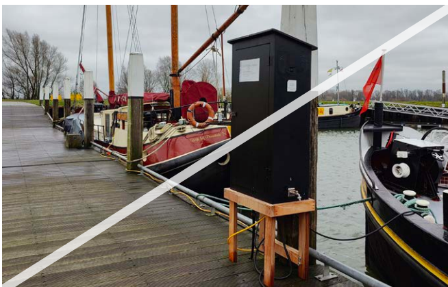
Niet gewenst: nutsvoorzieningen te aanwezig op de steigers en niet geïntegreerd in het ontwerp
