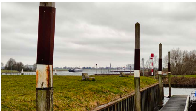
Verlengde meerpalen als geleidepaal voor drijfsteigers
