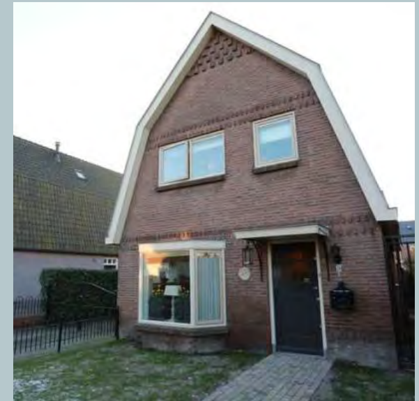
detaillering metselwerk, gootlijsten en trasraam
