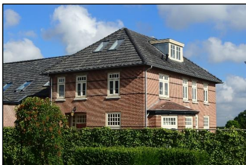
Woning die inpandig verbouwd wordt.
