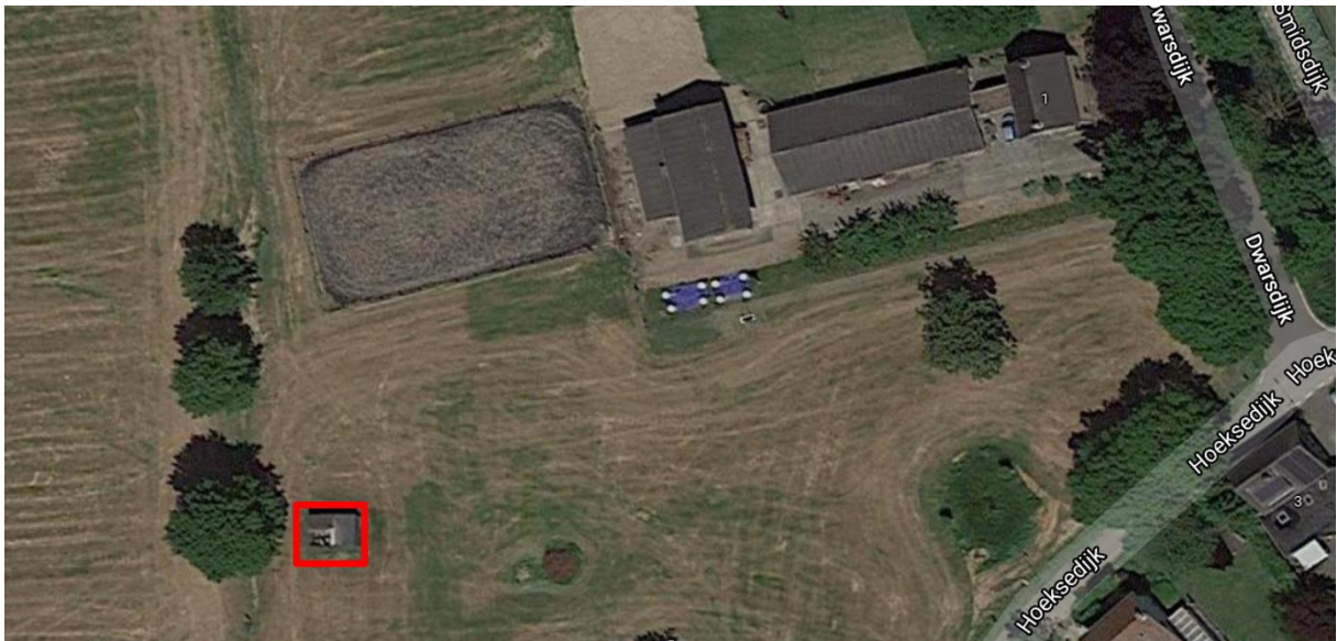
Afbeelding te slopen veldschuur aan de Dwarsdijk 1 in Cothen (aangeduid met rode lijn), bron: google.maps
