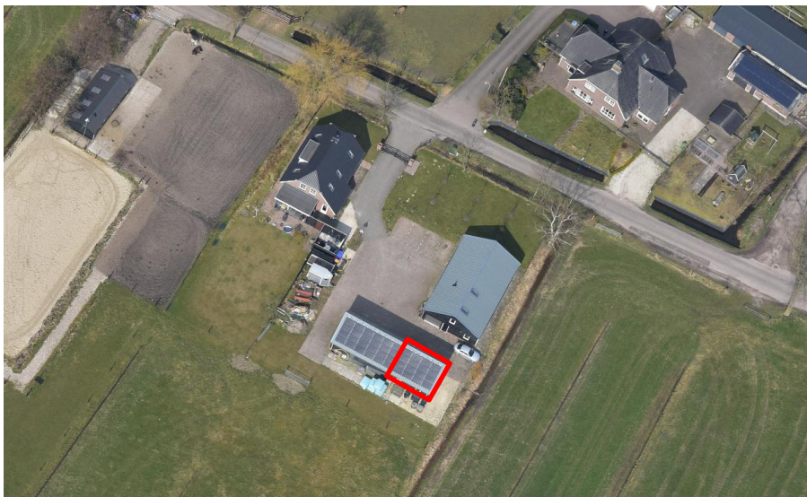
Figuur 2.7: Locatie Gooyerdijk 5, Langbroek
