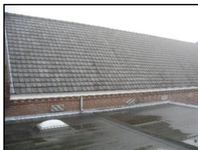
Figuur 7. Zuidwestelijk deel van het dak van de kerk.
