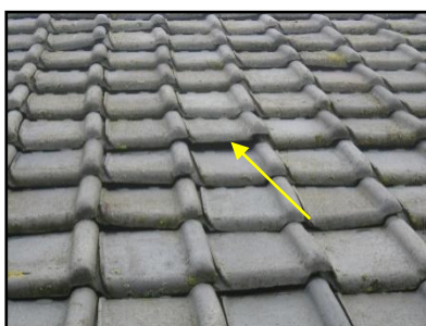
Figuur 12. Geschikte toegangsopening voor huismus en gierzwaluw tussen de pannen aan rechterzijde van de kerk.
