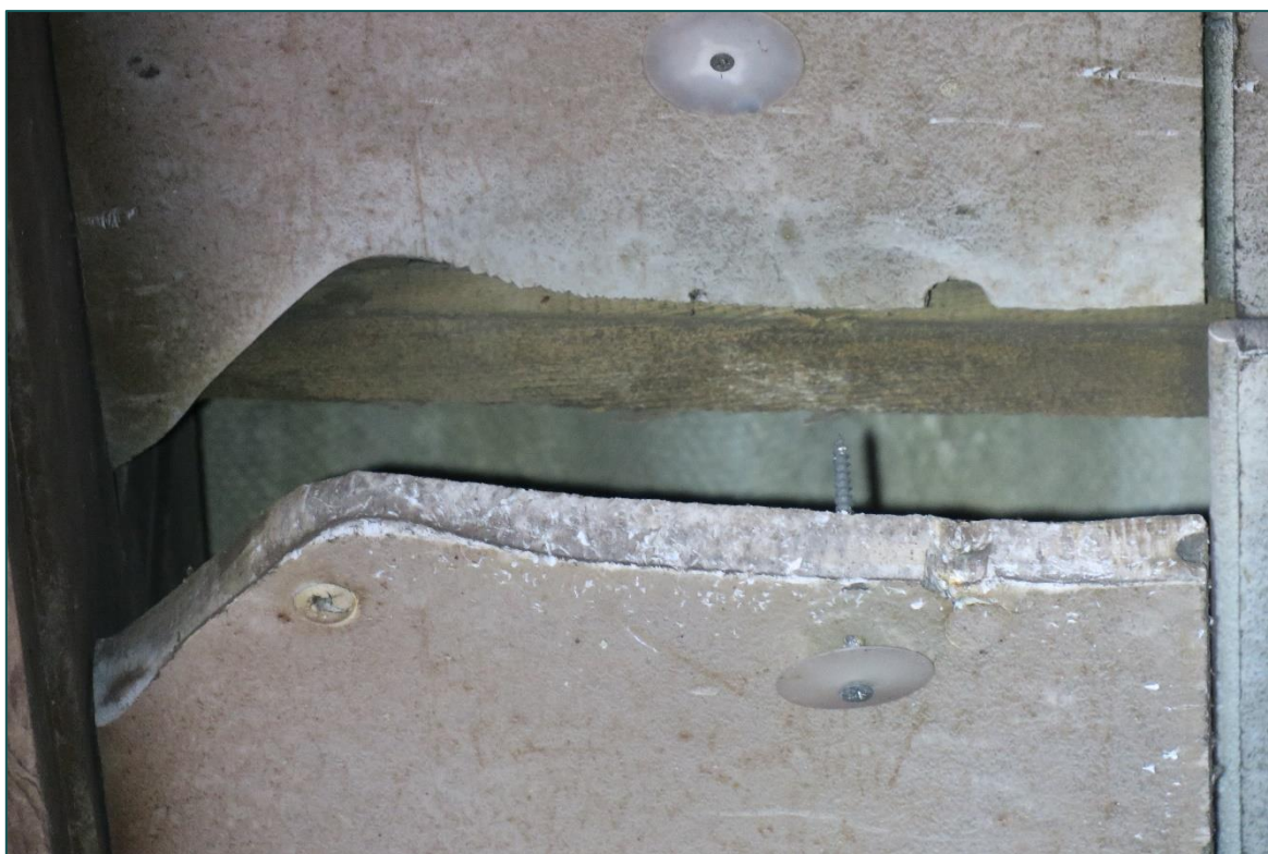
Figuur 2 Impressie van de opbouw van de daken waarbij er harde isolatieplaten onder het golfplaten dak gesitueerd zijn.
