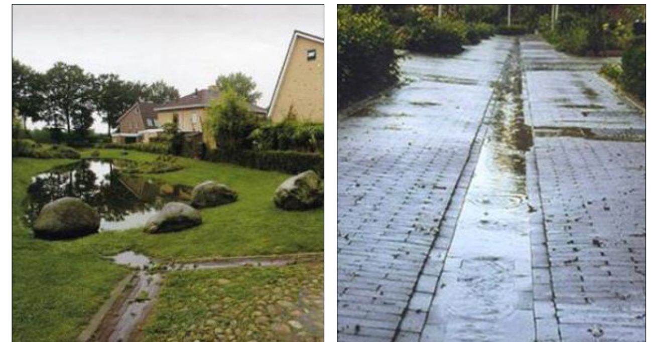
Figuur (39) Wadi en hemelwater afvoer.
