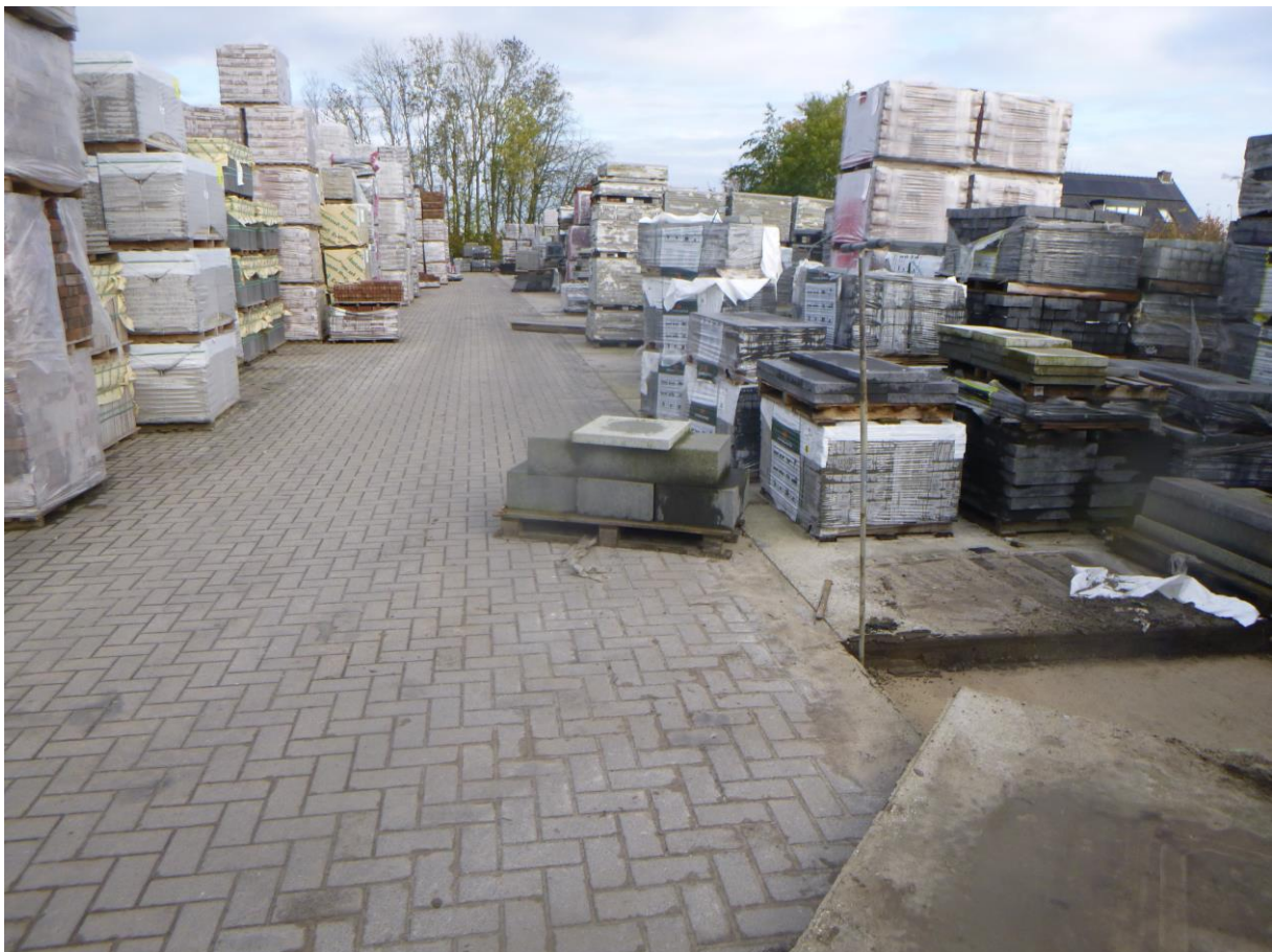
Figuur 18: Boorpunt 15 met één van de verwijderde stelconplaten (gezien in noordelijke richting).
