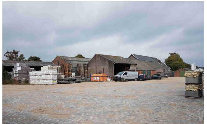
Foto 4: erf en voormalige veestallen en kapschuren (vanaf zuidoostzijde)
