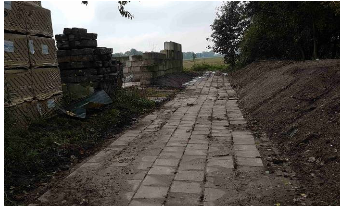
Foto 10: zuidwestelijk gedeelte locatie / grondwal
