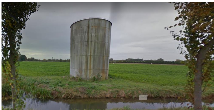
Figuur 4: Bouwwerk (mestsilo op perceel E2432). Google Streetview opname oktober 2016 vanaf de Broekweg richting het zuiden.
