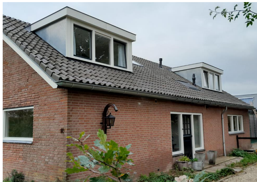
Figuur 5: Overzicht oostgevel van de woning
