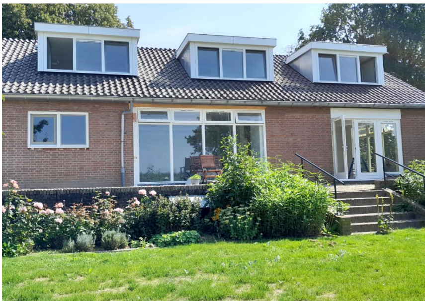
Figuur 7: Overzicht westgevel van de woning
