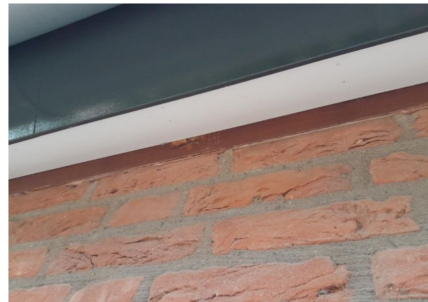
Figuur 6: Overgang van de gevel naar het dak aan de oostzijde
