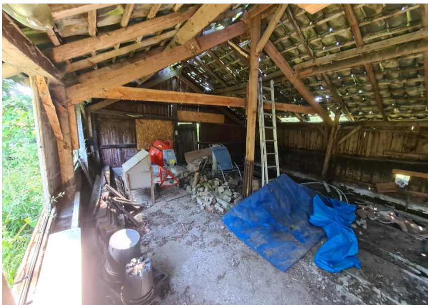
Figuur 12: Zuidelijk overzicht binnenzijde schuur
