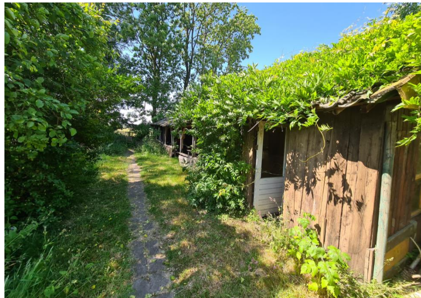
Figuur 5: Voorzijde schuur gezien vanuit het noordoosten
