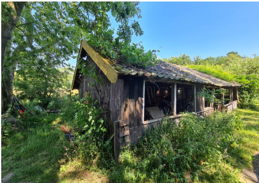
Figuur 4: Voorzijde schuur gezien vanuit het zuidoosten
