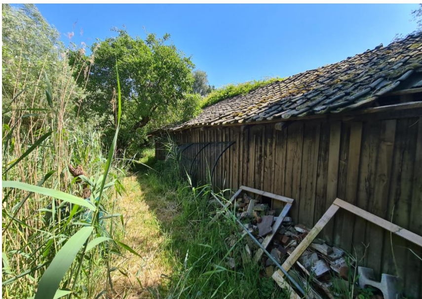
Figuur 7: Achterzijde schuur vanuit zuidwestelijke hoek
