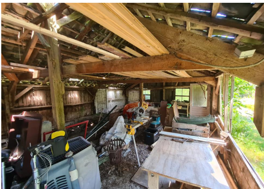
Figuur 133: Overzicht binnenzijde schuur gezien vanuit het oosten
