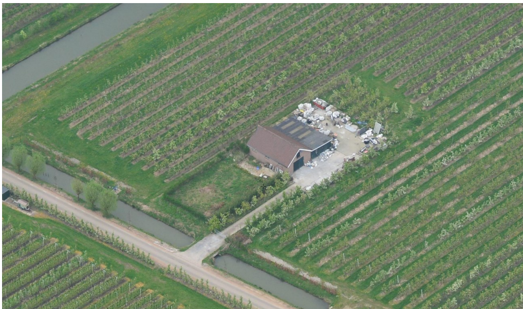
Luchtfoto van het gebouw
