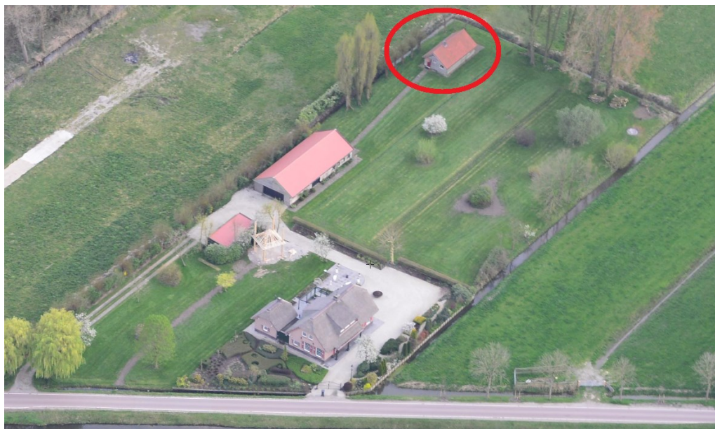
Luchtfoto van het perceel met rood omlijnd het betrokken gebouw
