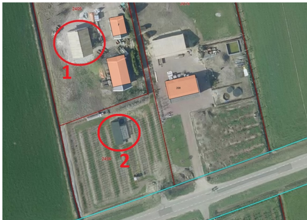
Luchtfoto met beide gebouwen
