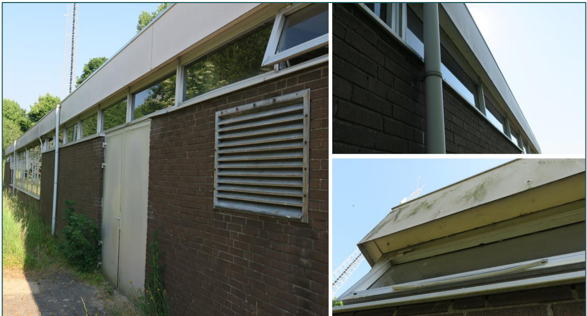
Figuur 5 Langs de gevel aan de zuidzijde is veel glaswerk aanwezig. De boeiboorden sluiten strak aan en in de muren zijn geen openingen aanwezig.
