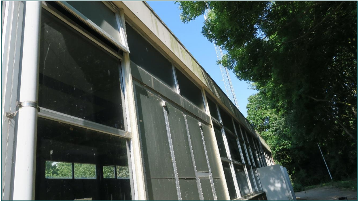
Figuur 2 De gevel aan de noordzijde van de planlocatie bestaat grotendeels uit glaswerk met daarboven boeiboorden.
