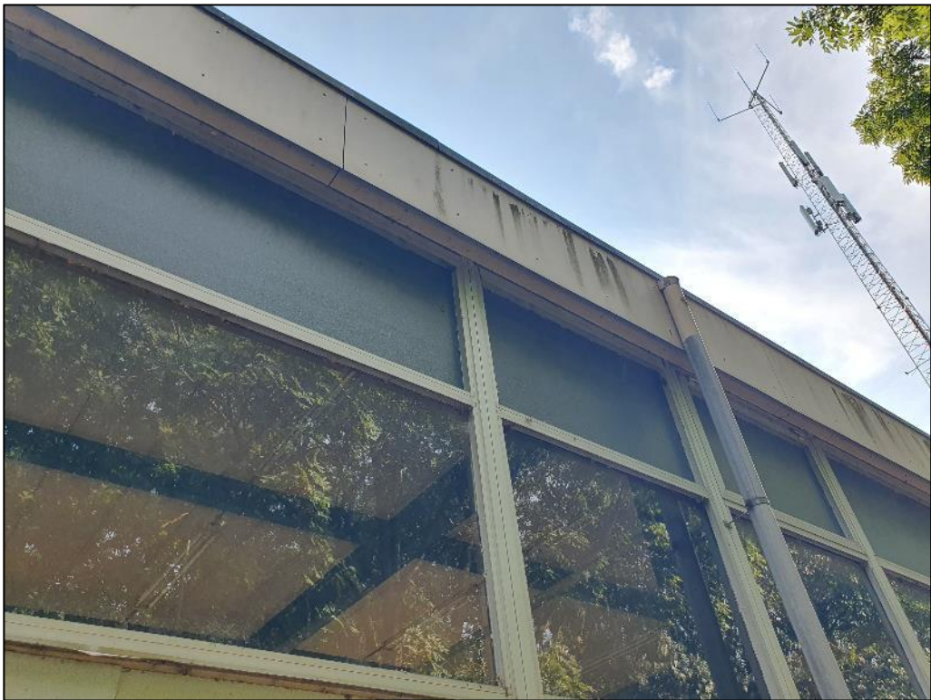
Figuur 4 De planlocatie bevat rondom nauwsluitende boeiborden op de dakrand.
