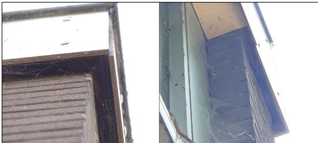
Figuur 3 Fotografische indruk van het aansluiten van de boeiborden op de achterliggende plank.
