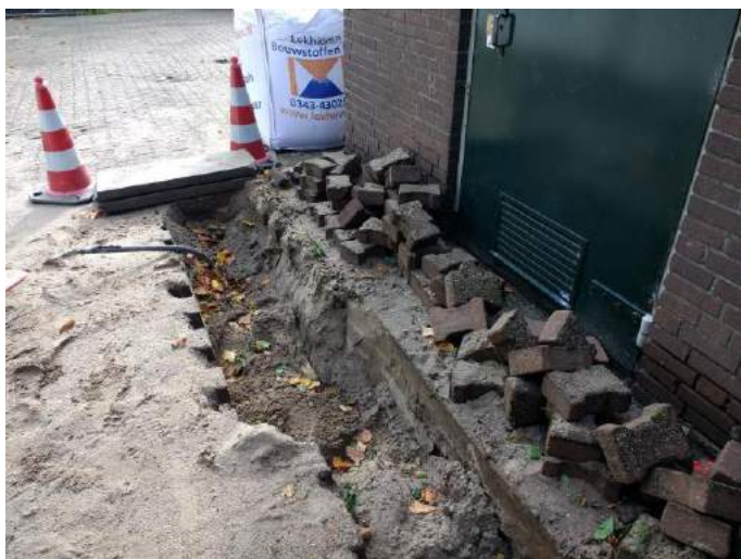
Figuur 7: Zintuiglijk schoon zand aanwezig onder de klinkers
