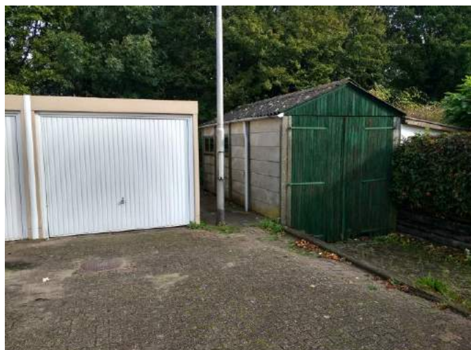
Figuur 4: Schuurtje met asbestverdacht dak op naastgelegen perceel
