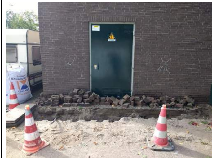
Figuur 6: Noordzijde locatie, straatwerk opengebroken
