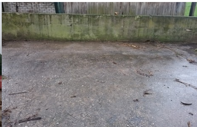
toelichting foto: restanten verwijderd van de betonplaat
