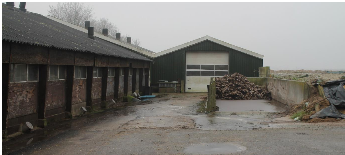
ALLE VERHARDING OP HET ERF WORDT VERWIJDERD
