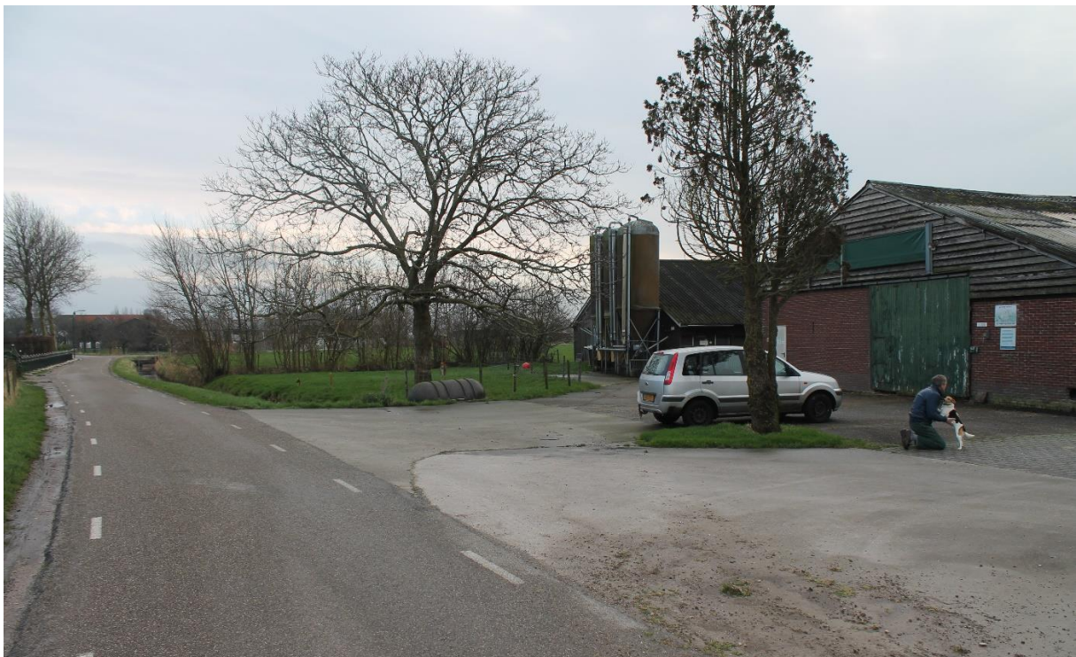
VOORZIJD VAN HET PERCEEL MET VERHARDING (TE VERWIJDEREN), EEN HOUTSINGEL EN EEN WEITJE MET EEN NOTENBOOM EN TWEE VAN DE DRIE DE TE SLOPEN BEDRIJFSGEBOUWEN
