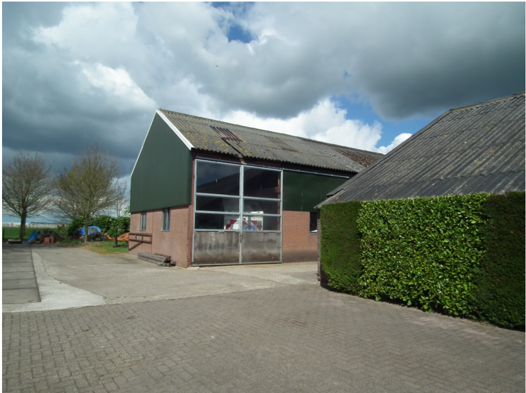
Figuur 4 Het overige terrein is met name verhard of ingericht als siertuin met gazon, hagen, struiken en bloemdragende planten.
