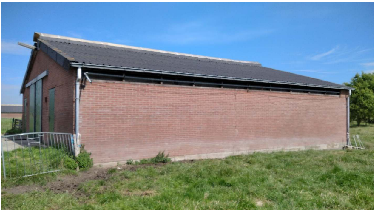
Schuur 2 (niet asbest verdacht dak)
