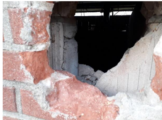
Figuur 4.2: Tochtgaten in de spouwmuur
