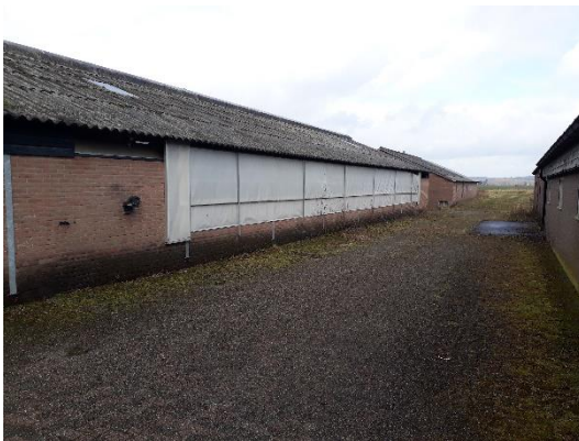
Figuur 2.2: Aanzicht van uit het zuiden
