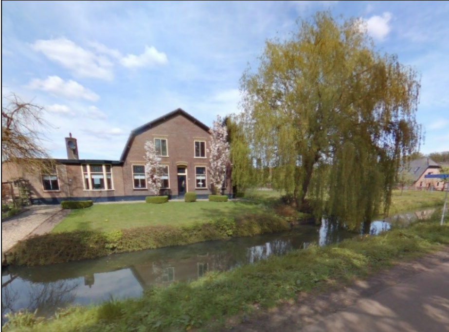
De boerderij Langbroekerdijk A 34 met links de aangebouwde 2 e bedrijfswoning
