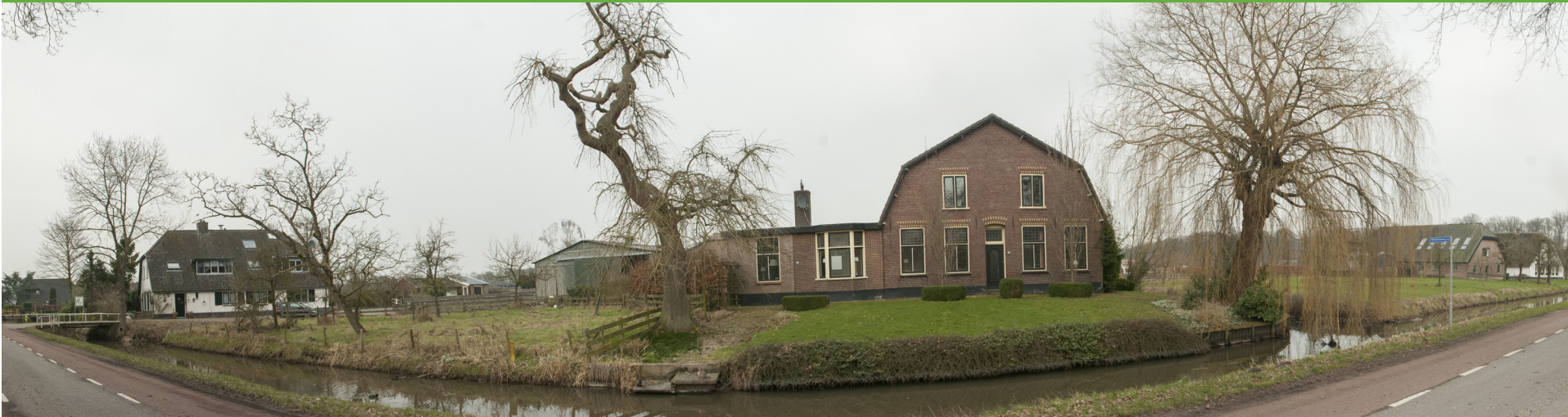
Door de aanbouw te slopen wordt de typische boerderij met mansardekap weer in oude luister hersteld.
