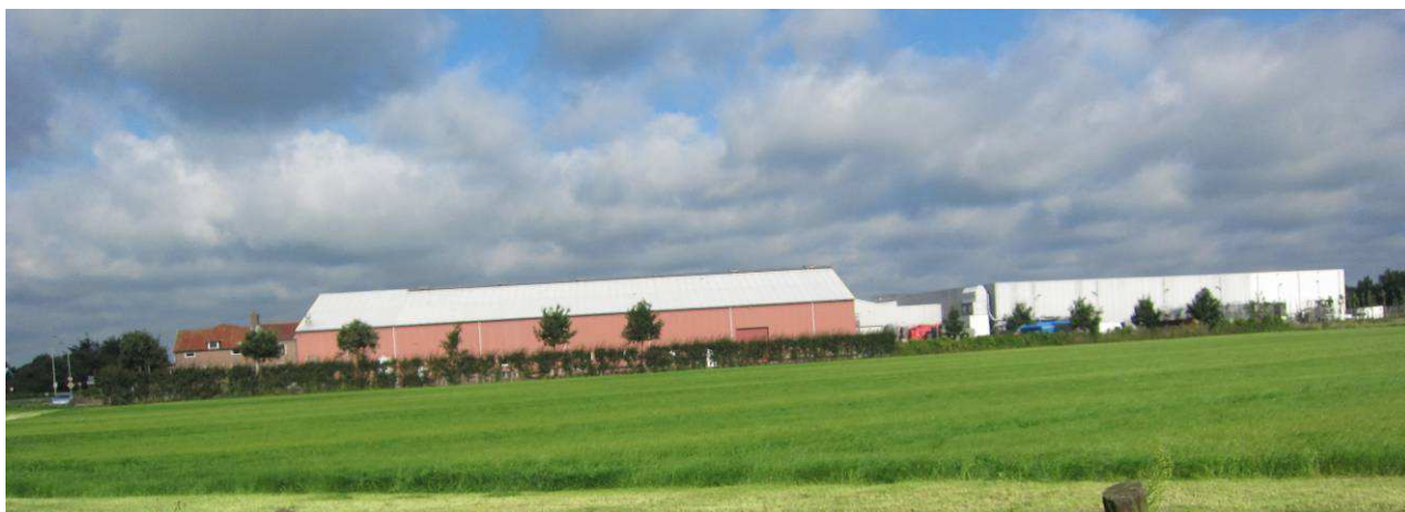
Perceel gezien vanaf oostzijde richting toegangsweg
