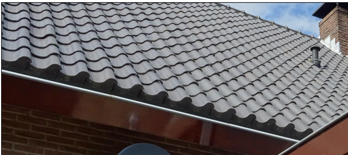
Figuur 7. Detailfoto dak van het woonhuis aan Slappedel 12. Er zijn geen geschikte ruimtes onder de dakpannen aanwezig voor de huismus of gebouwbewonende vleermuizen.
