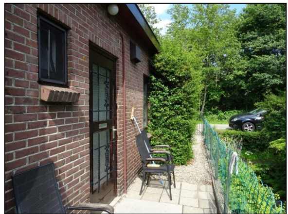
Figuur 4. Aanzicht zijkant te slopen bebouwing, gezien vanaf het zuidwesten.
