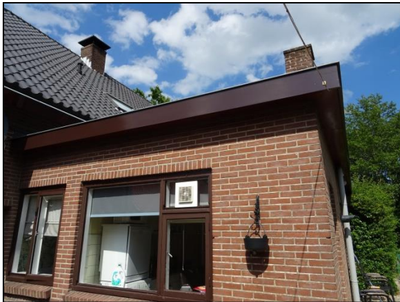
Figuur 5. Aanzicht achterzijde te slopen bebouwing, gezien vanaf het westen.
