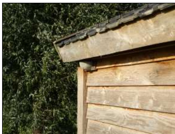
Figuur 11. Het open schuurtje is bedekt met dakpannen, zonder dakbeschoot.
