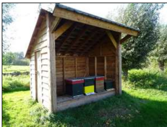
Figuur 10. Open schuurtje zonder dakbeschoot.
