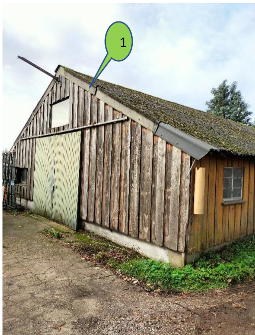
Foto 1: te slopen gebouw (1)
