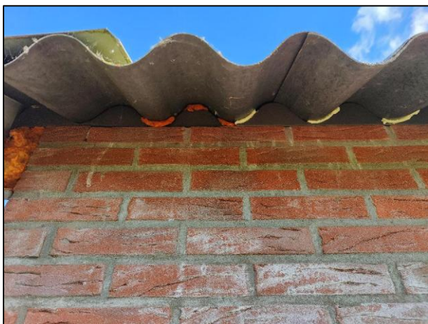
Dak van de stallen is niet toegankelijk voor steenmarters.
