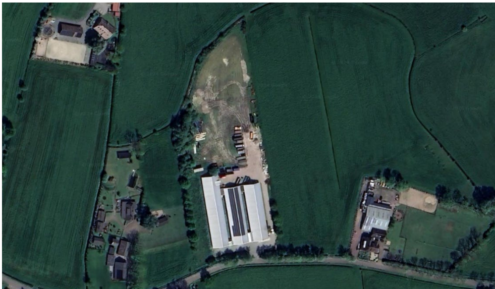
1 Luchtfoto huidige bebouwing
