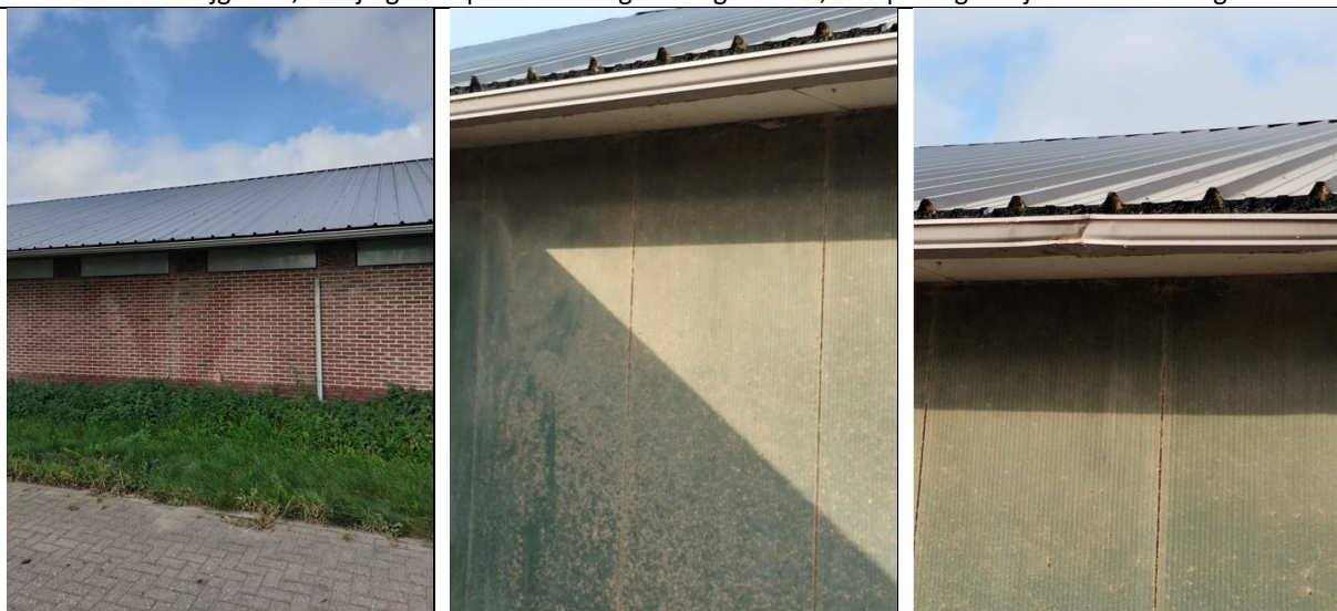
Het blikplaten dak is strak dicht en geïsoleerd, waardoor er geen holtes aanwezig zijn tot onder het dakvlak.
