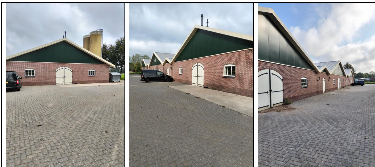
Foto's van de pluimveestallen genomen vanaf de voorzijde. De gemetselde delen van de gevels zijn volledig dicht.
